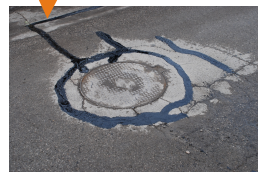
provedení zálivky strojem CIMLINE MAGMA 110 bez frézování
